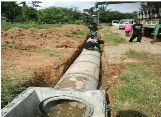
ภาพถ่าย: ขณะดำเนินการ
