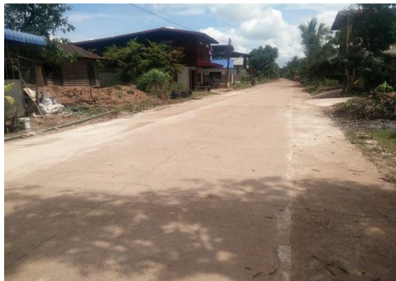
ภาพถ่าย: ดำเนินการแล้วเสร็จ
